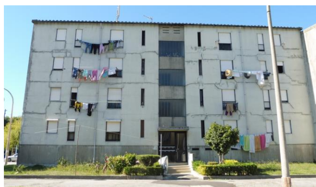
Antes da intervenção
