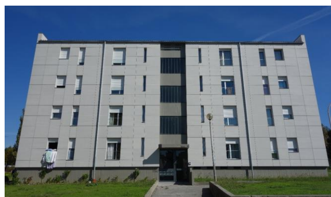
Depois da intervenção
