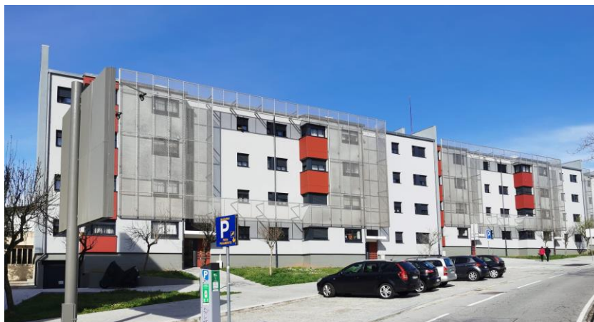
Fotografias da fase final das obras das Torres 3 e Torre 4, dos blocos 11, 12 e 13 do Bairro do Sobreiro e do Empreendimento Maia II – operações no âmbito da Eficiência Energética, programa Norte 2020 – reabilitação de fachadas, caixilharias e coberturas – empreitadas concluídas
