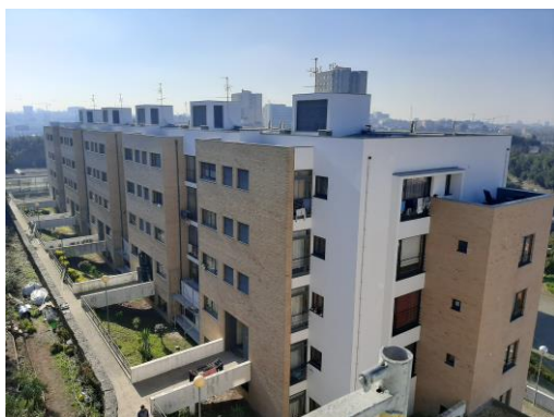
Empreendimento Municipal de Teibas II, 2.ª Fase – empreitada concluída
