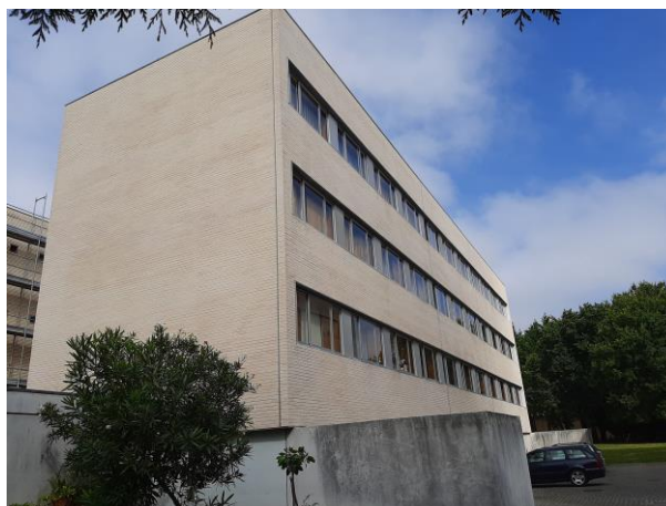
Empreendimento Municipal do Pinhal – Reabilitação de coberturas e caixilharias – empreitada concluída
