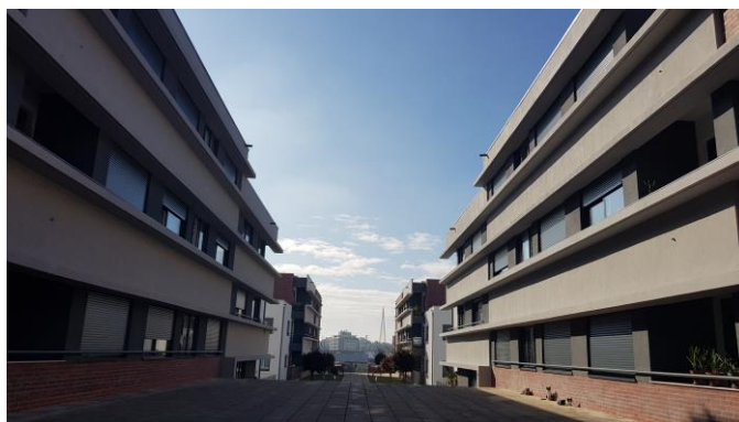
Empreendimento Municipal de Monte Vilar, 2.ª fase – empreitada concluída
