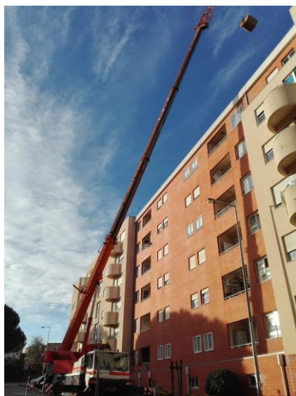
Empreendimento Municipal do Meilão – Reabilitação de coberturas e caixilharias – empreitada concluída
