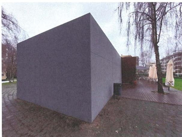
*Esplanada dos Altos - Substituição de revestimentos em Viroc – fachada ventilada*
