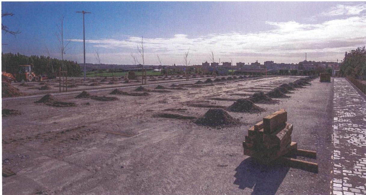
*Construção de parque de estacionamento de apoio ao TECMAIA – Ecoparque – estrutura do aparcamento em sequências perpendiculares ao arruamento de suporte (lugares assinalados com sulpas de madeira) – pavimento de tout-venant compactado, com especial atenção à drenagem natural do terreno e aos aspetos ecológicos da construção*
